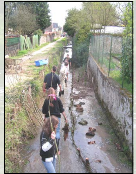
Chantier-école sur le Melotin à Reugny (avril 2006)
